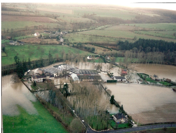
Figure n° 22 Usine à Cahan Source : DDE Calvados
